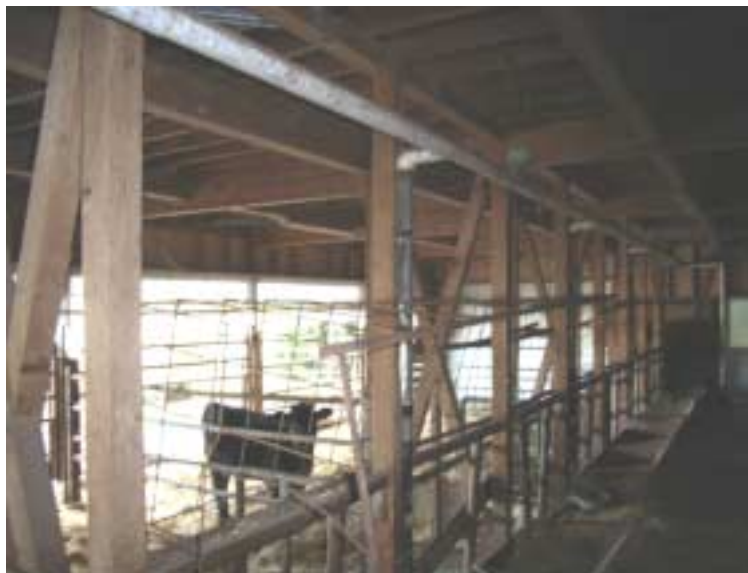
写真 4 その他の水道凍結防止電熱線の設置箇所（上：太陽熱温水器、下：家畜への給水装置）
