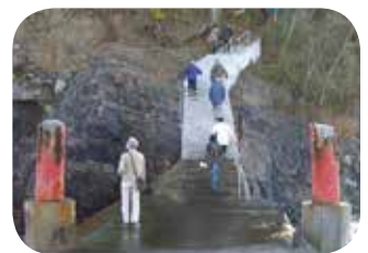
修復された階段を上る。手前は津波で破壊された鳥居
