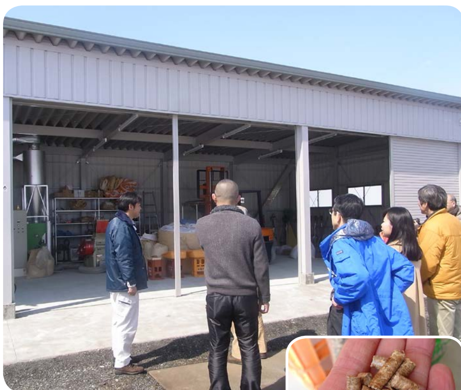
2014年に着工し、完成したばかりのペレット工場。 真新しい設備や加工現場に、興味津々の参加者でした！
