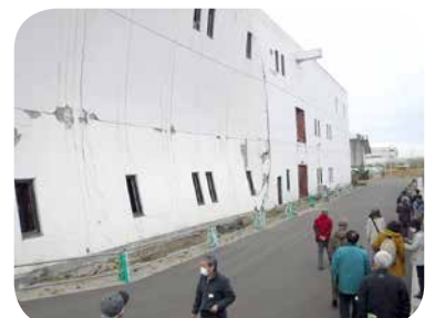
津波の直撃を受けた震災遺構
