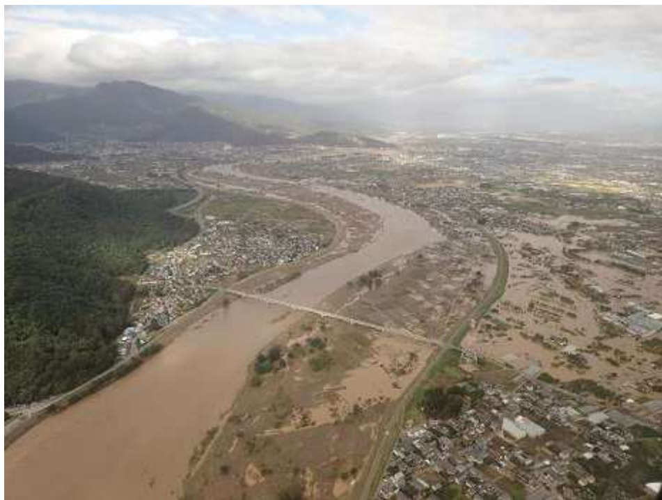
被災現場の様子（長野市）
