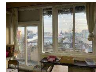
学校の断熱改修の実証
