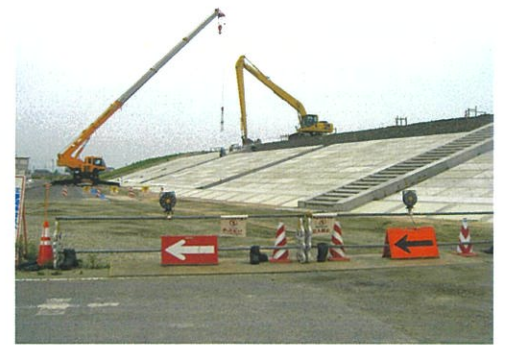
工事の進む防潮堤と拡幅予定の道路。この堤防の階段の所に集会所、道路の左側三角コーンの辺りに地蔵尊堂があった。
