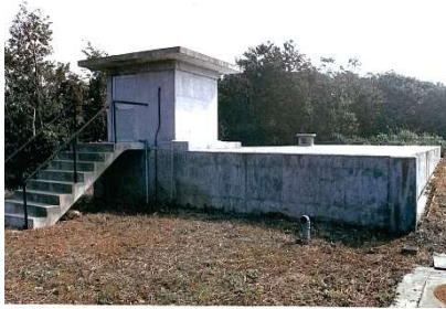
●石浜配水池 410m 3
